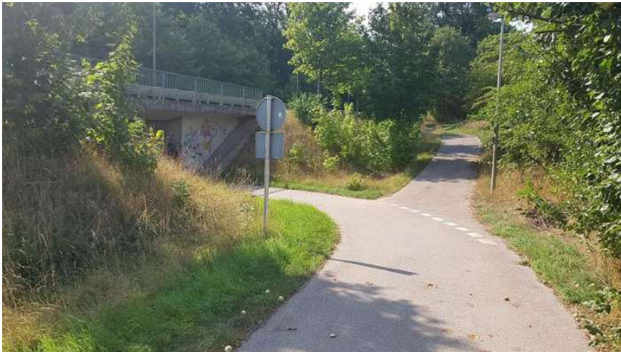
Abbildung 19: Planfreie Querung einer klassifizierten Straße mit unterstützender Markierung auf dem Radweg
