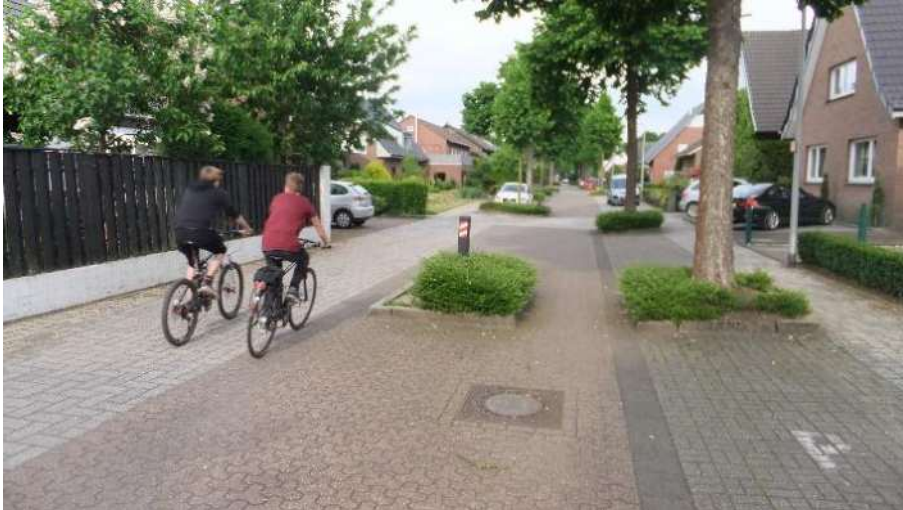
Abbildung 7: Oberflächenstruktur und die Anordnung der begrünten Inseln — u.a. in der Fahrbahnmitte — reduzieren die Geschwindigkeiten in diesem verkehrsberuhigten Bereich (VZ 325) spürbar.
