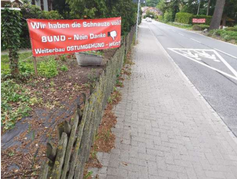
Abbildung 12: Die Radverkehrsanlage ist nicht als solche erkennbar.
