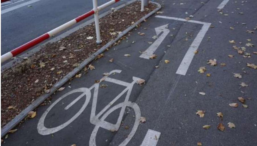
Abbildung 18: Induktionsschleife für den Radverkehr an einer Lichtsignalanlage
